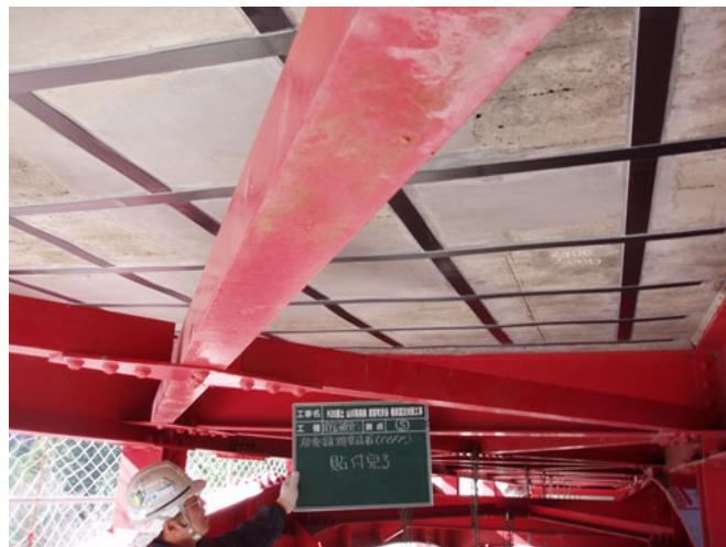
図 3-4-1 床版下面への CCFP-CABOCON の貼付例
